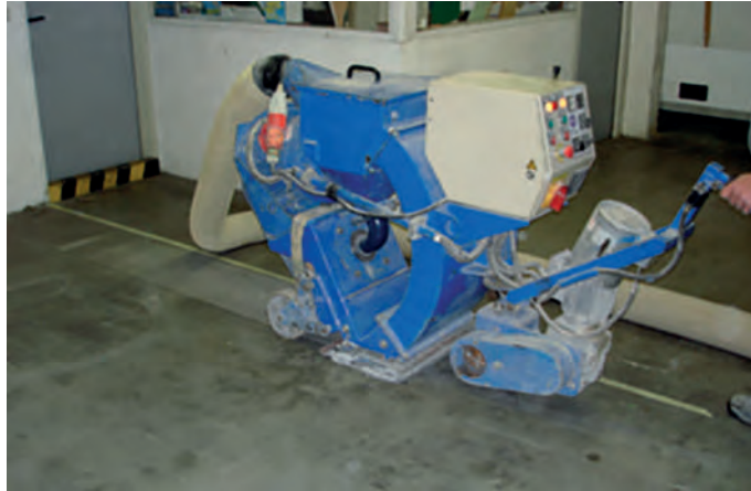
Remoção de betão deteriorado, argamassas de superfície e outros elementos que possam afetar a adesão do sistema, bem como a obtenção de rugosidade superficial adequada.
